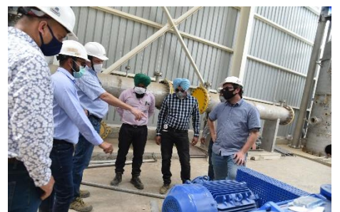
VERBIO bio-refinery India, Punjab, Chandigarh
