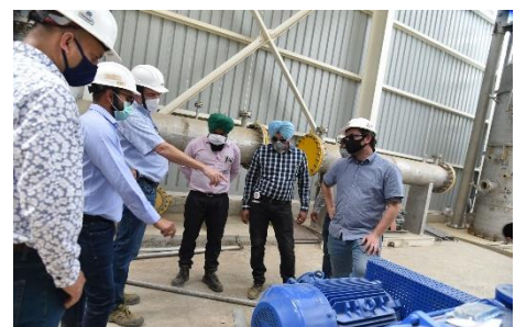
VERBIO Bioraffinerie in Indien, Punjab, Chandigarh
